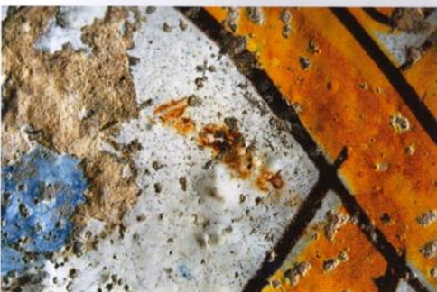
Fig. 7 - Particolare che mostra lo stato di conservazione del rivestimento, si noti la macchia di ruggine sullo smalto bianco.
